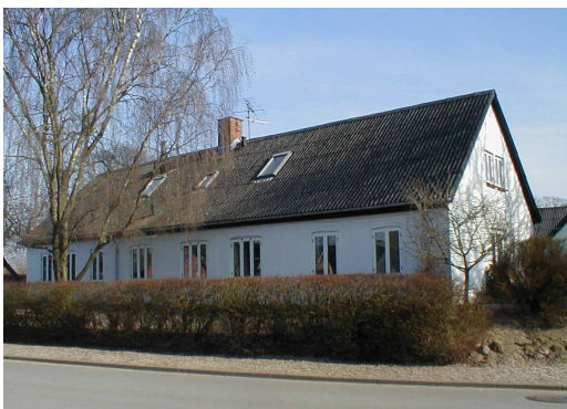
Stuehus. facade mod nord
